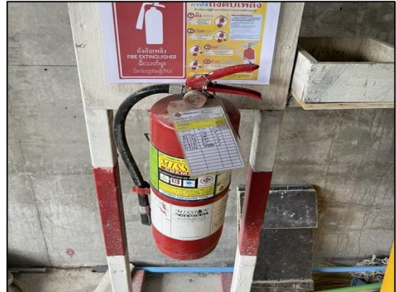
รูปที่ 3-31 การตรวจสอบถังดับเพลิง
