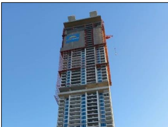
รูปที่ 3-40 Mesh Sheet
